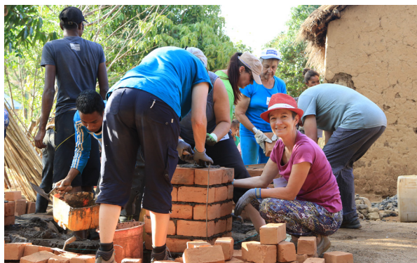
Solidarité et partage sur le chantier à Ambohibola, à Madagascar, en 2019.
